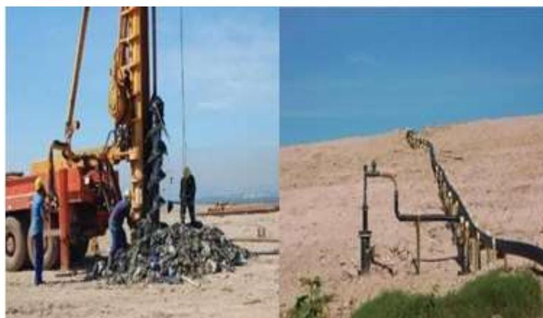
**Figura 18** - Perfuração de poço para captação de biogás do AMJG, traçado do Gasoduto de fornecimento de biogás purificado para a Reduc (desativado), trecho da rede de captação de biogás e vista da instalação da rede de captação de biogás no AMJG.
